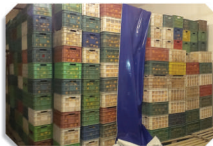
استفاده از پوشش برزنتی جهت ایجاد فشار منفی در کانال هوا
